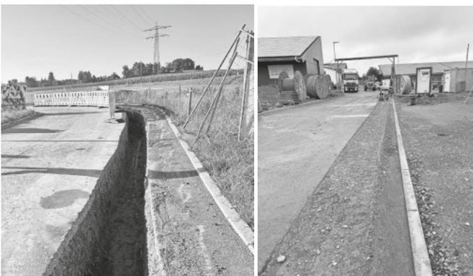
Aktuell befindet sich der Bautrupps im Gewerbegebiet von Hattenweiler. Hier schreiten die Arbeiten ebenfalls gut voran: Der Leitungsbau geht ordentlich voran und die ersten Glasfaserhausanschlüsse sind bereits installiert.
