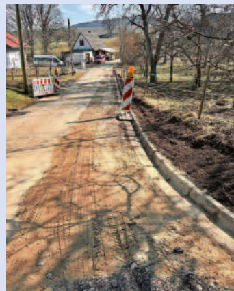
Glasfaserausbau und Stromleitungsbau Moos
