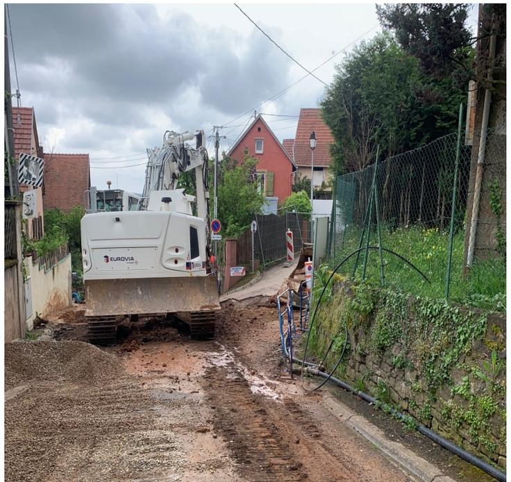
En parallèle à ces travaux de mise en place de réseaux sur la voie publique, la propriété de chaque riverain concerné est individuellement raccordée aux réseaux publics au fur et à mesure de l'avancée du chantier.
