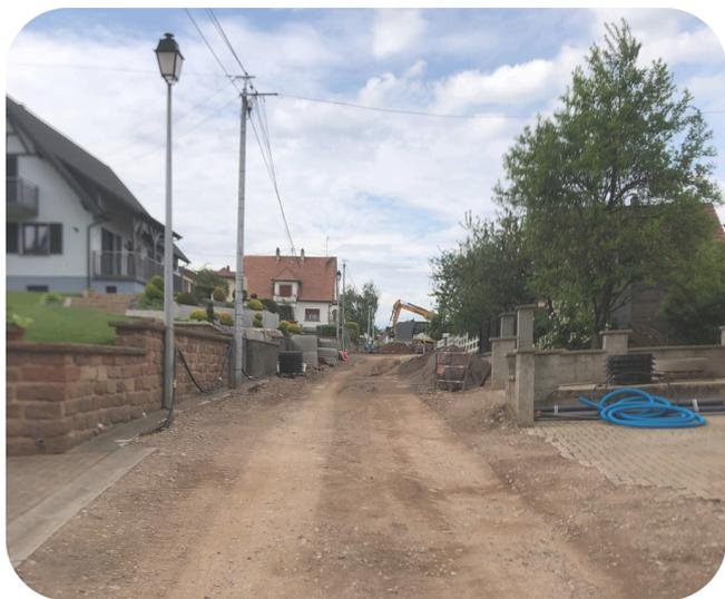
Les travaux de la rue de la Batteuse avancent à un très bon rythme et à l'heure où vous lirez ces lignes les conduites principales d'eau potable, d'eaux pluviales et d'assainissement sont posées sur l'ensemble des 400m linéaires ainsi que les raccordements en limite des propriétés privées.
