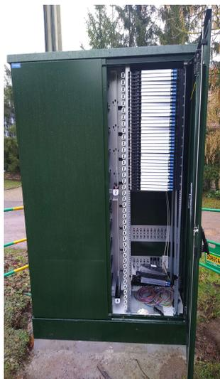
Les travaux de déploiement du réseau fibre optique Rosace sont en cours à Heiligenberg. L'implantation du sous-répartiteur optique desservant les 330 foyers de la commune a eu lieu près du réservoir d'eau. Les points de branchements optique sont en cours d'installation sur les poteaux ainsi que des implantations de chambres souterraines.
