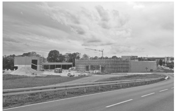
Die große Baustelle an der Riedheimer Straße am Ortseingang von Markdorf ist weithin sichtbar.
